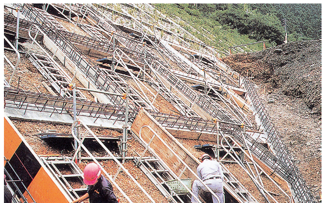
法面現場設置
