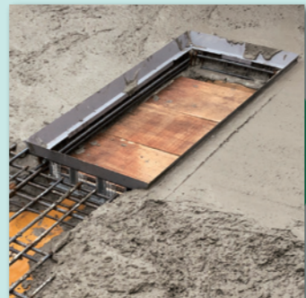
スラブコンクリート打設
