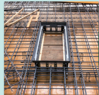
スラブ筋・開口補強筋 配筋
