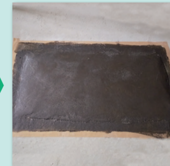
埋め戻し完了
