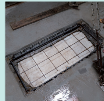
底板型枠・ワイヤーメッシュを設置
