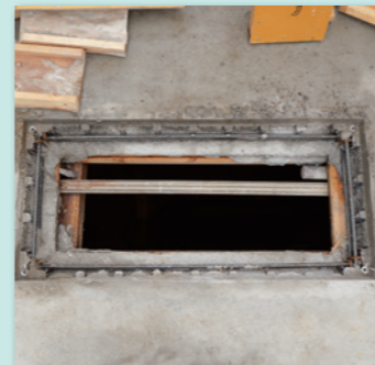
仮設開口完成
