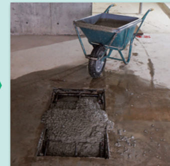
閉塞コンクリート打設
