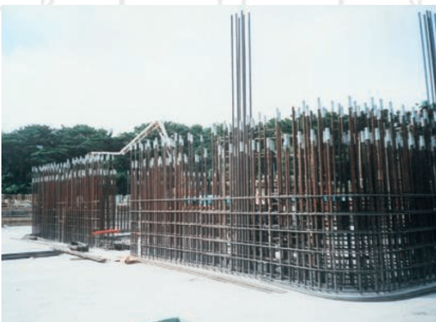
発電所の煙突工事（Ⅰ型）
