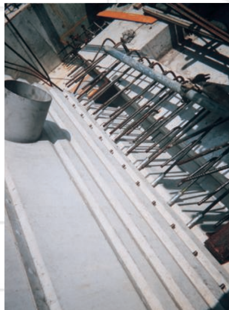
PC 部材との取り付け部（Ⅰ型）
