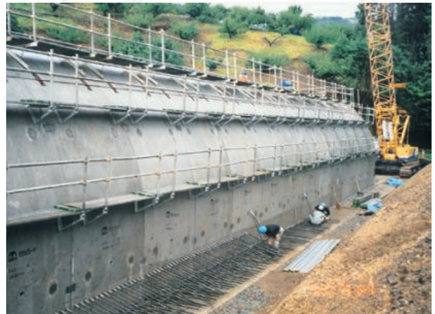
トンネル後打ちスラブ接合 (I 型)
