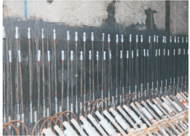
地下鉄壁主筋（Ⅱ型）
