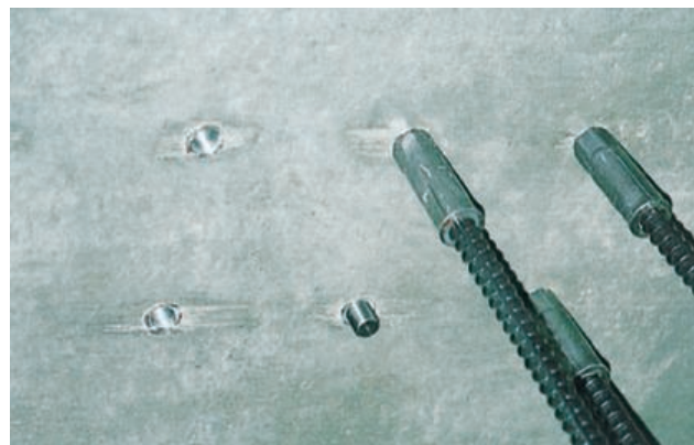
鉄筋取付状況
