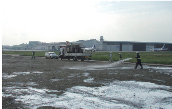
ハイドロシーダーによる施工状況
