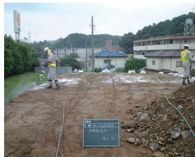
工事用道路(非通行部)
