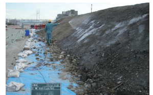
散布の様子 (法面)
