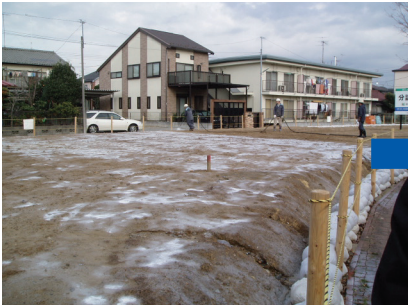
施工直後の状態
