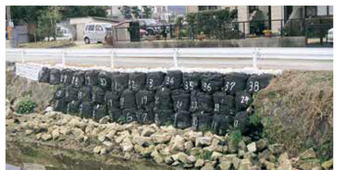
押さえ盛土工 法面の地すべり対策として押さえ盛土をした事例
