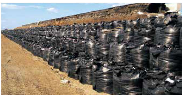
仮防潮堤 崩壊した防潮堤の応急復旧に用いた事例
