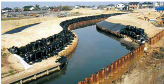
土留め工 水路の土留め工として用いた事例
