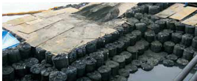
土留め工 施工ヤードの土留めとして用いた事例
