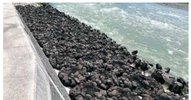
根固め被覆 根固めブロックの被覆材として用いた事例
