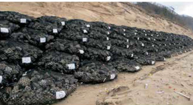
浸食対策 砂浜の海岸浸食対策で用いた事例
