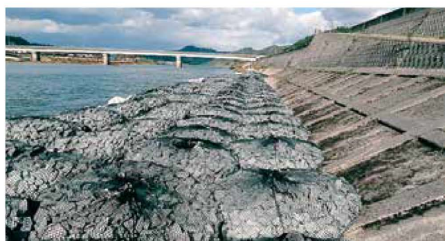
間詰工 護床工の間詰として現地製作・施工した事例
