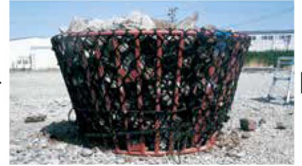
3 中詰め材投入
