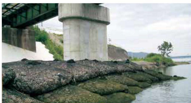
根固め工 鉄道の橋脚根固めとして用いた事例
