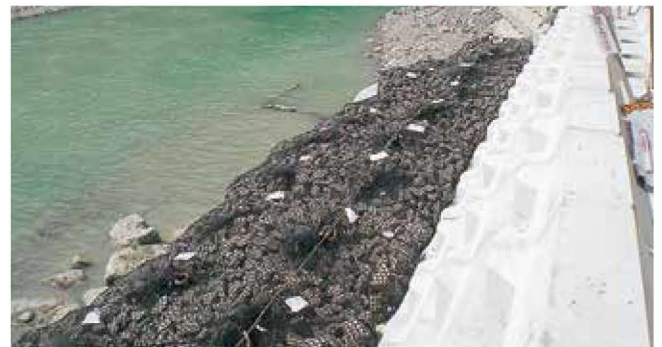
根固め工 工所用仮設道路の根固めに用いた事例
