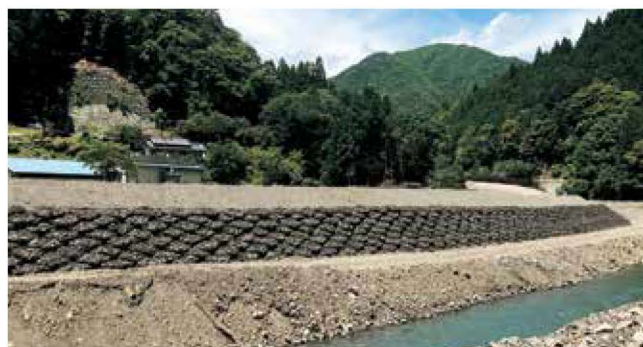
護岸工 水路の護岸として用いた事例
