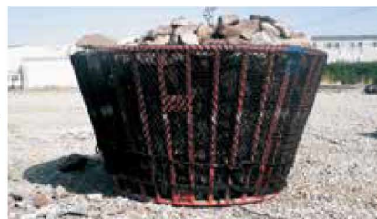
3 中詰め材投入
