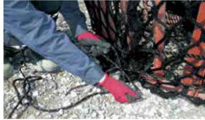
2 網地を型枠に拘束
