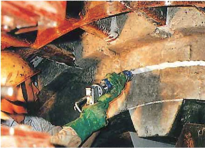
コンクリートの打ち継ぎ
