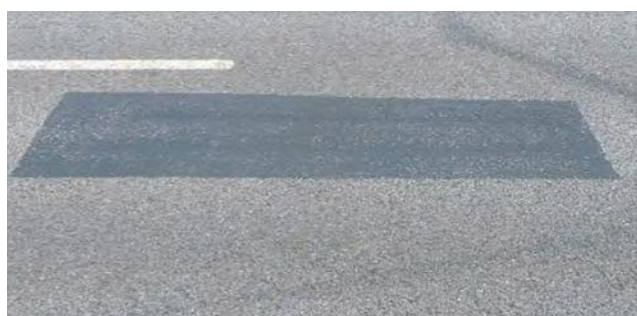
▲施工直後の状況
