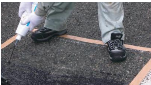
1.主剤と硬化剤を混合し、施工面上へ吐出します
