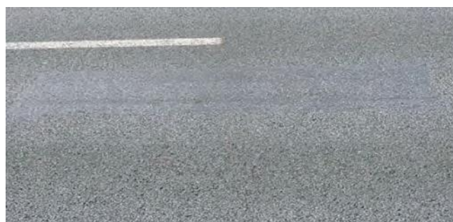
▲施工後約6ヶ月の状況
