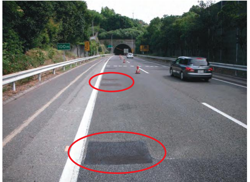
▲排水性舗装のひび割れ補修状況
