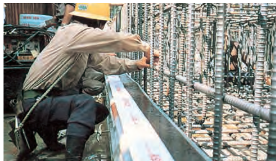
原子力発電所コンクリートスラブ打継面にPタイプ使用▶
