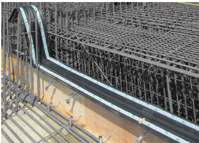
③ 止水板設置状況
