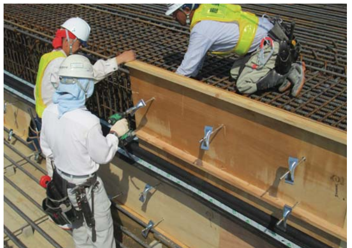
④ 型枠設置状況
