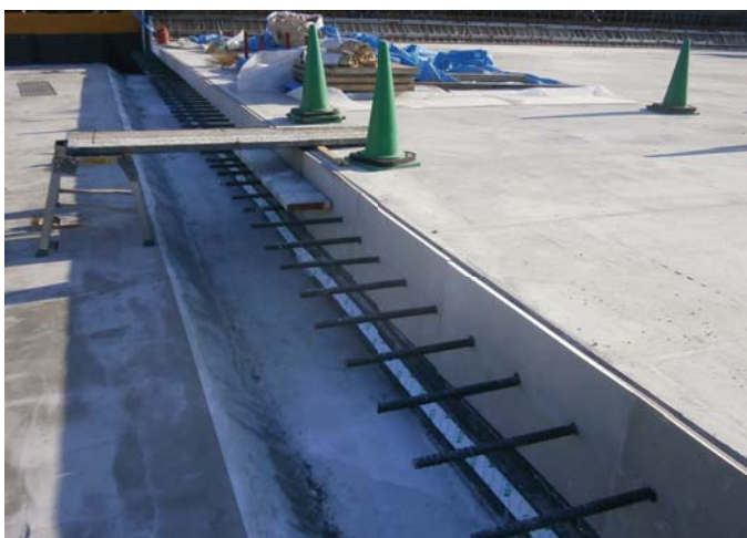
⑦ 先行型枠脱型完了
