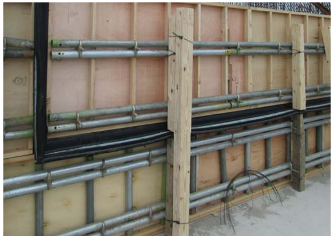
⑥ 型枠設置完了(コーナー部)
