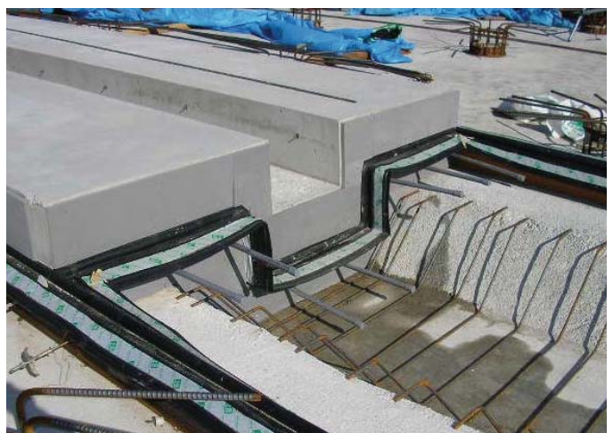
⑧ 先行型枠脱型完了
