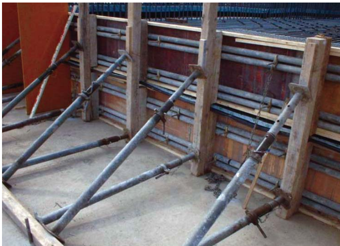
⑤ 型枠設置完了
