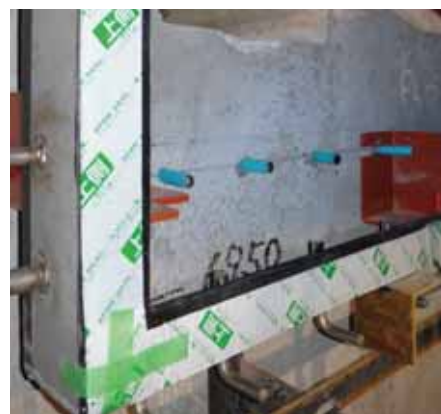
⑥ 下部鋼製枠設置完了
