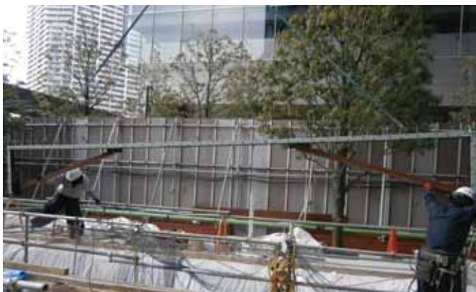
⑦ 上部鋼製枠建込状況
