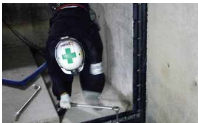
⑧ ゴム取付け状況
