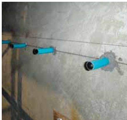
② アンカー設置完了
