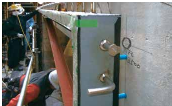
⑧ 鋼製枠位置決め状況
