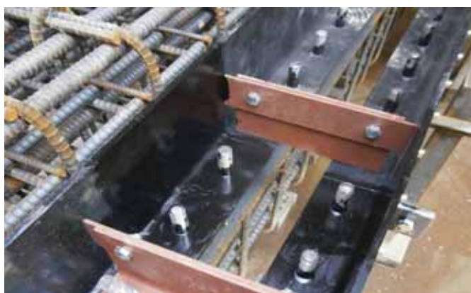
③ 鋼製枠ジョイント部
