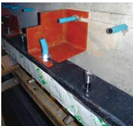
④ 下部連結材取付け完了
