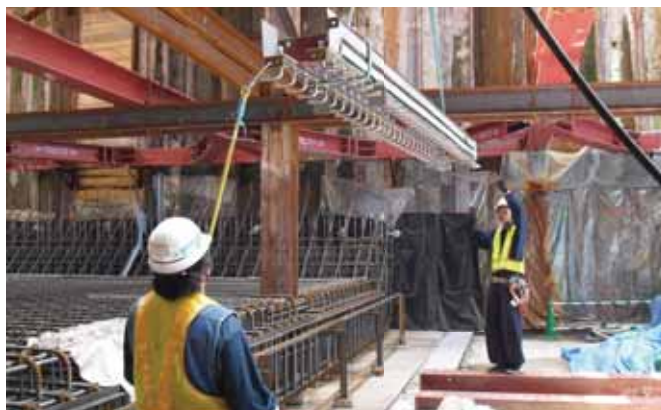
② 鋼製枠設置状況
