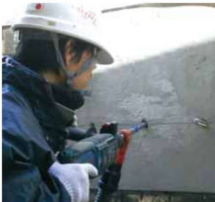
① 削孔状況
