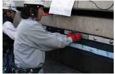
⑥ 押え板取付け状況
