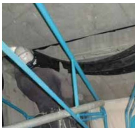
⑩ 伸縮ゴム取付け状況
