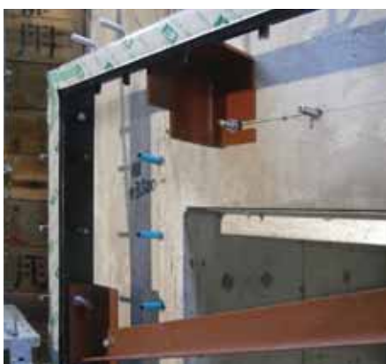
⑨ 上部連結材取付け完了
