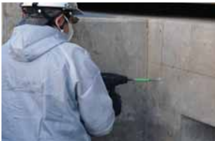
① 削孔状況
