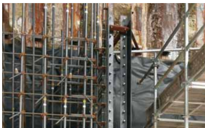
④ 鋼製枠設置完了
