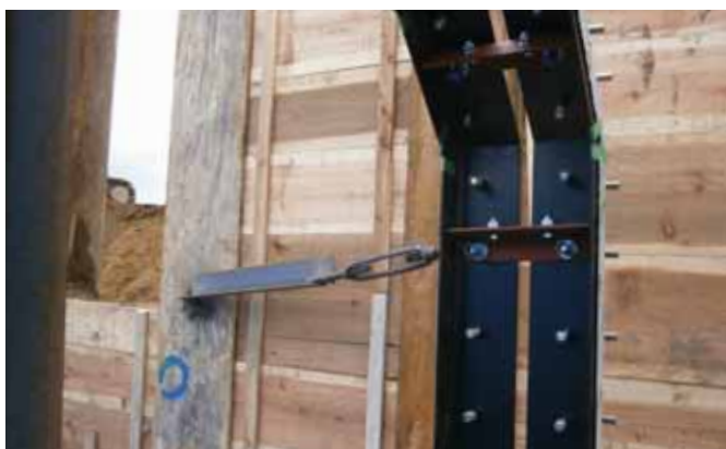
⑤ 控え材設置完了
