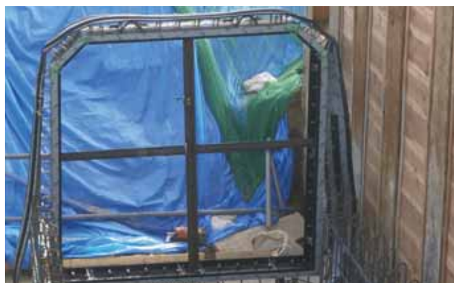
⑥ 鋼製枠設置完了
