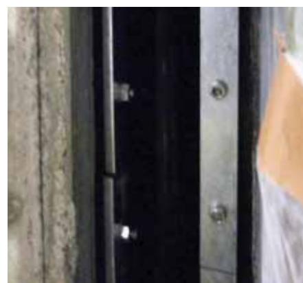
⑪ 伸縮ゴム取付け完了
