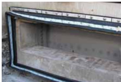
⑧ 伸縮ゴム取付け完了
