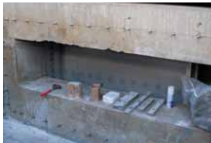
② アンカーボルト設置完了
