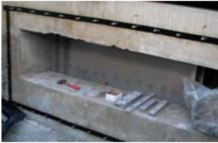
④ シール材(スパンシール)貼付け完了
