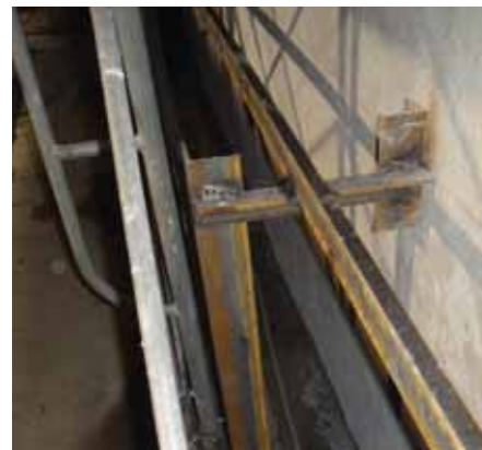
③ 架台設置完了
