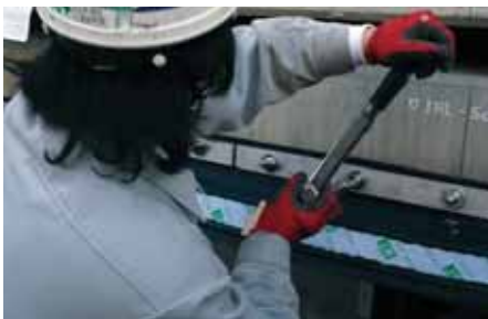
⑦ 締付けトルク確認状況
