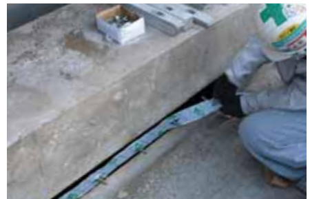
③ シール材(スパンシール)貼付け状況
