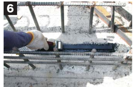
⑥ ハンドローラーで止水材の上表面を圧着してください。
