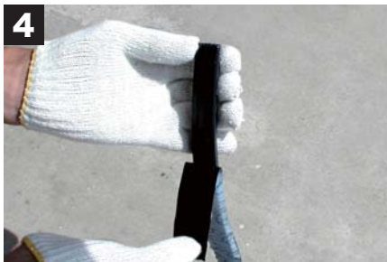
④ ネオспанシールDSWの離型フィルムを剥がしてください。 (注)この面には接着剤は塗布しません。
