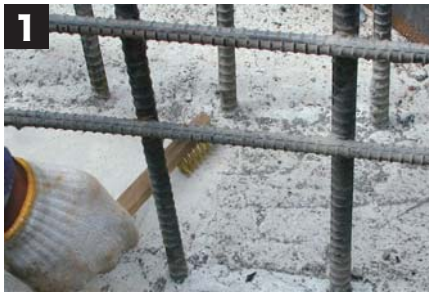
① 表面に付着しているゴミ、レイタンス等をワイヤーブラシで取り除いてください。
