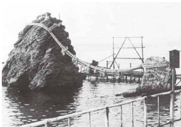
▲伊勢二見ヶ浦の夫婦岩は、風雨や波浪による浸蝕、破損が激しいので、エスダインジョイナーWを使って保全工事。(昭和40年、41年施工)
