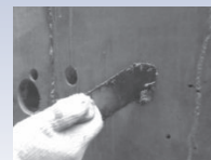
モルタル埋め
